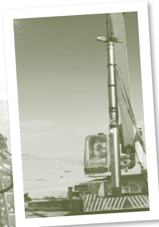
SONDAJE PARA LA CONSTRUCCIÓN DE POZO PARA LLEVAR A CABO EL BOMBEO
